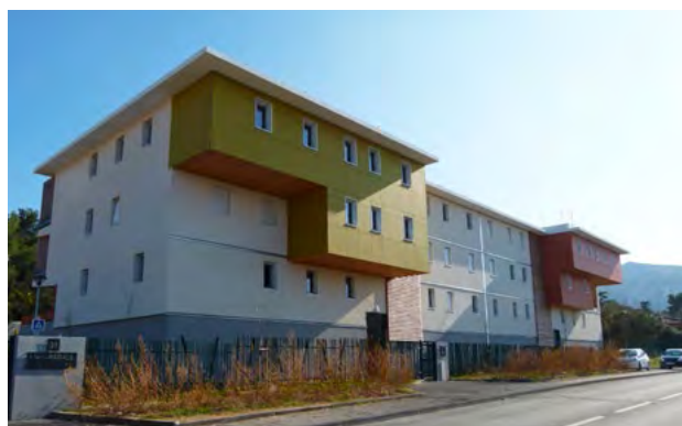
Éléments en surplomb insérés contre un immeuble en béton
