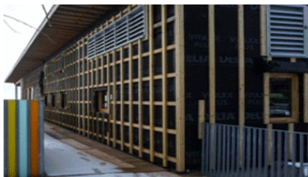
Parois recouvertes d'une membrane pare pluie noire, avant la pose du bardage.
