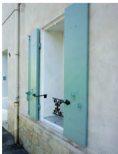
Bâtiment ancien, où la fenêtre est occultée par des volets en bois plein épais et dont l'embrasure comporte une feuillure sur le pourtour.
