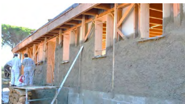
Mise en œuvre d'un mur de béton chaux chanvre, par projection du béton contre une structure bois.
