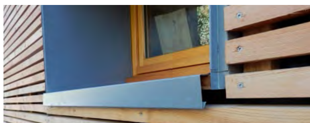
Bavette métallique sous une fenêtre
