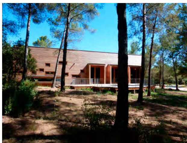
Salle des sports (Commune de Saint-Marc launegarde). Architectes : Battisti et associés. © EnvirobatBDM
