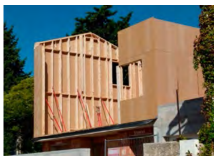
chantier en ossature bois, avant la pose de l'isolant
