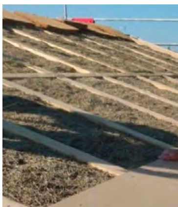
Pose de panneaux sur une charpente bois isolée avec des bottes de paille. Les panneaux de fermeture permettent de protéger les couches les plus sensibles de la toiture du dépôt de brandons.
