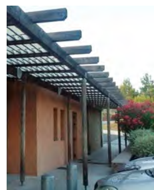
Pergola en bois couverte par des lames brise-soleil métalliques.
